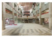
Pour permettre l'accès au chantier, une « faille » de 90 r de long, 10 m de large et 20 r de profondeur a été découpée dans les dalles des parkings evistants
