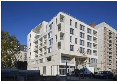
Le bâtiment et son épandage progressif avec, à droite, la barre voisine en R+10.
