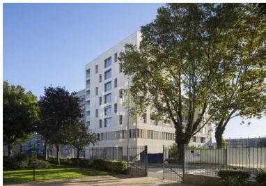
Le long de l'avenue Lénine, la façade d'accès au parking, à l'encore un traitement des angles offrant un effet de retournement et une continuité visuelle sur l'ensemble du bâtiment.
