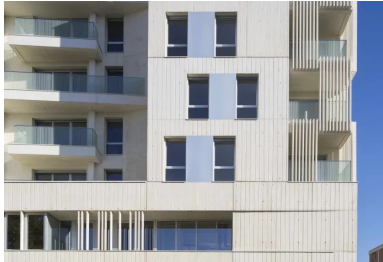
Jeu de lignes renforcé par la variété des matières développées en façade.
