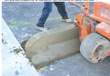
Les grandes étapes de la réalisation des bordures en béton extrudé
