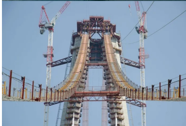
Les pylônes sont de section triangulaire variable...
