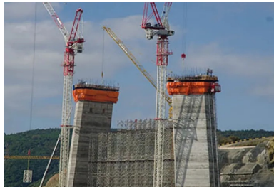
Ils sont réalisés jusqu'à 208 m de hauteur avec un coffrage glissant.
