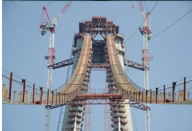
Les pylônes sont de section triangulaire variable...
