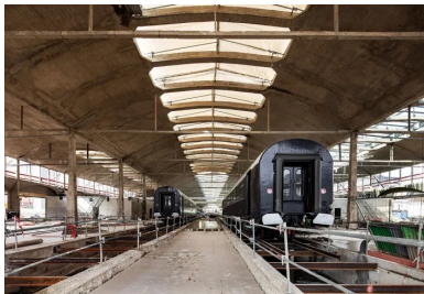
Le projet conserve la mémoire logistique et ferroviaire du site.
