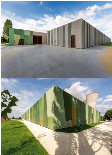
Angle nord-est du réservoir, quelques-uns des 356 panneaux de béton déclinés en 23 teintes.
