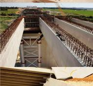
Long au total de 345 m, le viaduc du vistre comporte un ouvrage droit de 261 m de type quadripoutres en béton armé
