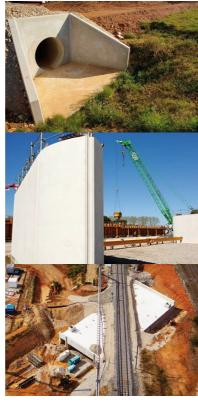
Buses et dalots facilitent l'écoulement de l'eau sous la plate-forme.
