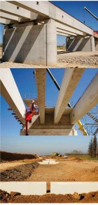
Les estacades sont constituées de poutres préfabriquées en béton armé reposant sur les piles.
