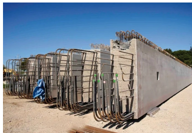
Les poutres préfabriquées en béton armé des estacades du viaduc du Lez et de la Lironde.
