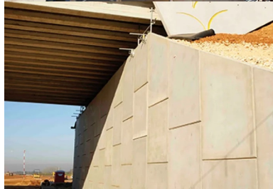
17 ouvrages, dont le pont-route de la rd 42 à Caissargues (gard), font appel à la technique sur appuis voûtés : des falcilles en béton armé constituent le parement.
