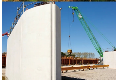
Une pile du futur viaduc (576 m) du Lez et de la Lironde.
