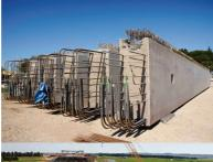
Les poutres préfabriquées en béton armé des estacades du viaduc du Lez et de la Lironde.
