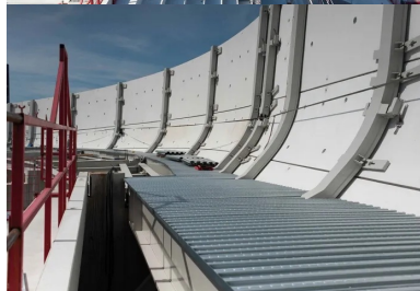
Détail du système d'accroche des coques préfabriquées.
