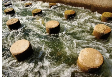
Les 113 cylindres de béton cassent la dynamique de l'eau et permettent aux poissons de se reposer lorsqu'ils remontent le courant.
