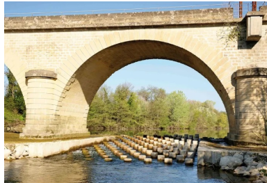
Un suivi environnemental a été assuré pendant toute la durée des travaux qui ont eu lieu de mai à septembre 2014.
