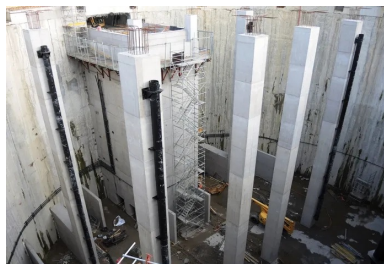
Deux des files de poteaux à l'intérieur du bassin de stockage.
