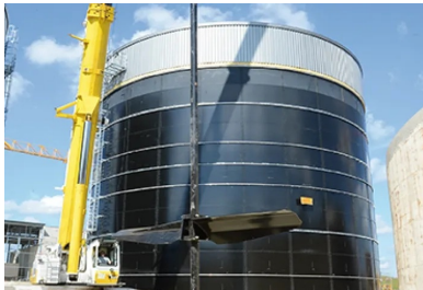
Phase de levage d'un agitateur pendulaire...
