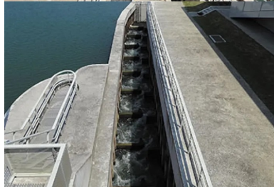
Passes à poissons à chambres successives dans les barrages de vives-eaux et Chatou.
