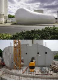
Vue de profil, partie émergée de la station de pompage réalisée en béton projeté
