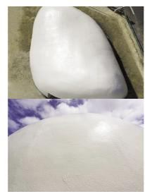
Le grain de la structure : une résine imperméabilisante de 2 mm, projetée au pistolet.
