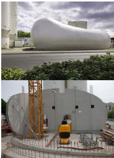
Vue de profil, partie émergée de la station de pompage réalisée en béton projeté.
