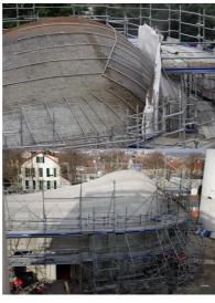
L'ensemble de la coque béton armé de 20 cm d'épaisseur, est nie
