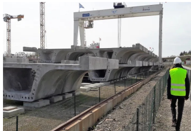
La manutention des 973 voussoirs dans l'aire de stockage est effectuée par un portique mobile.
