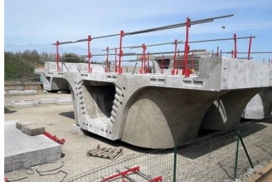
Chacun des voussoirs possède des caractéristiques et une géométrie uniques.
