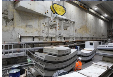
Puits d'entrée du tunnel. manutention des voussoirs de 6 tonnes chacun.
