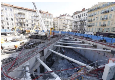
Station Durandy : butonnage des parois moulées d'une des « boîtes ».
