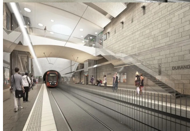
Future station Durandy : les parois moulées seront recouvertes de parements de pierre.
