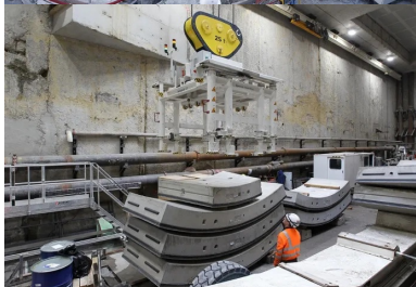
Puits d'entrée du tunnel, maintenance des voussoirs de 6 tonnes chacun.
