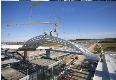
Elles sont mises en place avec une grue de 1 200 t et de 100 m de flèche.
