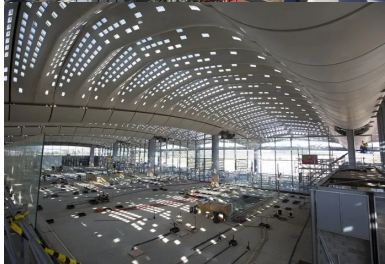
En sous-face, les coques habillent la structure et forment avec les palmes une surface à double courbure.
