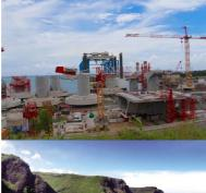
Une fois leur phase de maturation terminée, les embases et têtes de piles sont embarquées directement depuis l'aire de préfabrication sur la barge (au fond en bleu) qui les mettra en place.
