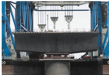
La barge zourite permet de transporter en une fois la tête de pile surmontée du mégavoussoir sur pile.
