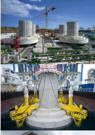
Les semelles de fondation cylindriques des embases de piles sont très massives : de 20 à 23 m de diamètre pour 4 m d'épaisseur.
