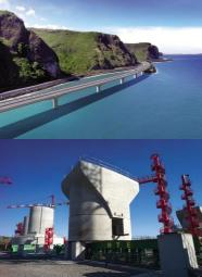
Long de 5,4 km, le viaduc forme des travées de 120 m et repose sur 48 piles en mer.
