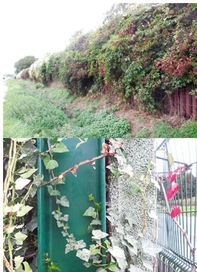
Réalisables en plusieurs couleurs (gris ciment, vert et, ici, rouge), les panneaux peuvent être végétalisés, jusqu'à être complètement dissimulés sous le feuillage.
