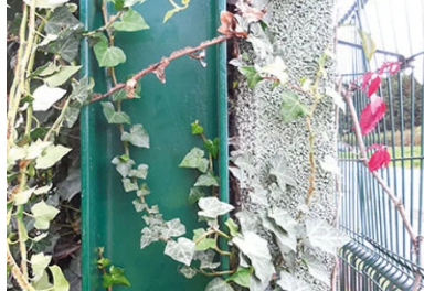
Des poteaux de soutien en forme de H maintiennent les panneaux d'un poids unitaire de 2,5 tonnes, qui sont rigides grâce à un voile de béton de 10 cm, situé à l'arrière. Ils sont équipés de grilles anti-tags.
