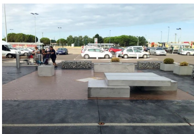
Le béton noir imprimé en motifs légers est traversé par une bande de guidage au sol pour sécuriser le déplacement des personnes aveugles ou malvoyantes (PAM). À l'arrière du banc en béton, une bande d'éveil à la vigilance (BEV).
