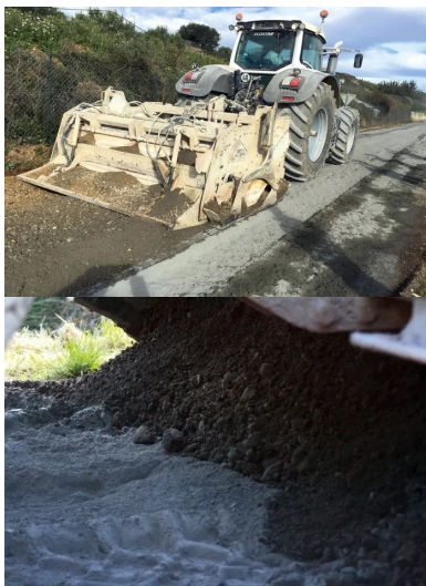
En action sur le chemin du Bousquet, en octobre 2015, le « tracteur muni d'un malaxeur » loué à la société nimoise Ecostab, spécialisée dans le traitement des sols.
