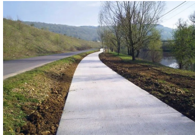
La réalisation de la piste cyclable a nécessité l'utilisation d'une Miller MI-1800 pour couler 500 mètres linéaires en moyenne par jour.
