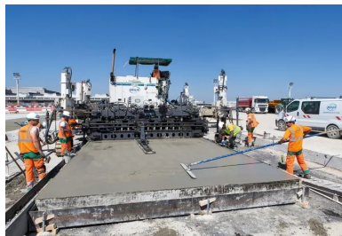
La Wirtgen SP-500 d'Agilis en action.
