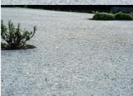
Le scintillement du béton tiré à la règle est obtenu par l'intégration en plusieurs passes d'éléments métalliques (3/6 mm) à raison d'un dosage très spécifique par mêtre carré et d'une finition lissée à l'hélicontère.
