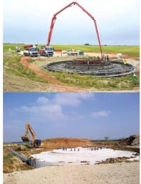
Opération de coulage du béton : le massif de fondation circulaire d'une E82/2300 mesure environ 9 m de rayon, soit 250 m2 de surface.
