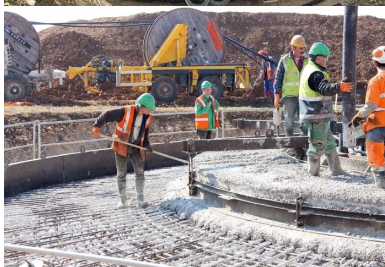
Pour réaliser les massifs de fondation des éoliennes, environ 100 kg d'armatures sont nécessaires par mètre cube de béton.
