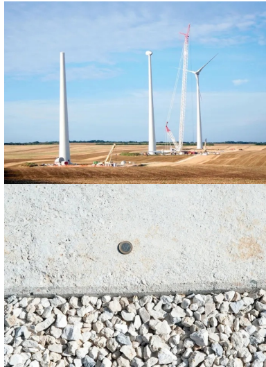
Des éoliennes E82/2300 en cours d'assemblage.
