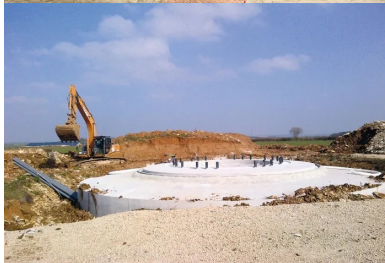
Un massif de fondation d'éolienne nécessite la mise en œuvre d'environ 400 m 3 de béton. Poids total : un millier de tonnes.
