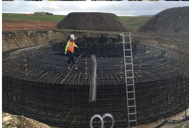
Mise en place du ferrailage par la Société d'armatures spéciales.
