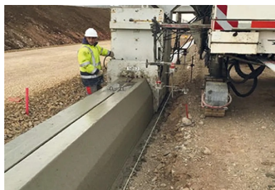
Mise en œuvre d'un caniveau à fente.
