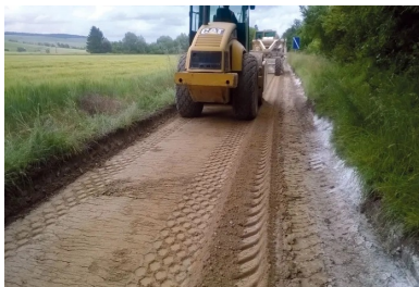
Le compactage partiel est réalisé immédiatement après le malaxage pour ne pas laisser le matériau foisonné exposé aux intempéries.
