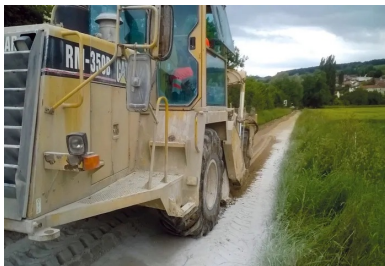
Étape essentielle pour assurer l'homogénéité du matériau : le malaxage, réalisé sur 35 cm de profondeur et sur une largeur de 3,50 à 4 m.
