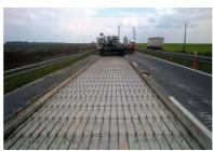
Deux phases de l'intervention sur l'A71 : mise en place des barres en acier haute adhérence HA 16 le mardi et bétonnage à la machine à coffrages glissants le mercreti
