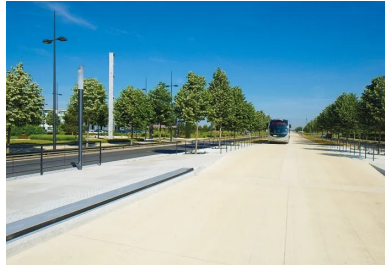
La voie dédiée au BHNS se distingue des voiries existantes par sa couleur claire.
