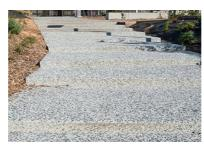
Réalisé en béton désactivé, le cheminement en pas-d'âne qui mène à l'entrée du pôle Brassens-Camus
