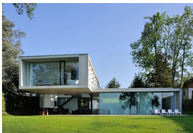
Le premier étage s'élanche en direction du lac par un généreux porte-à-faux
