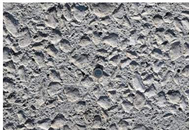
Le béton squamé intégrant des granulats concassés de calcaire clair 20/40.
