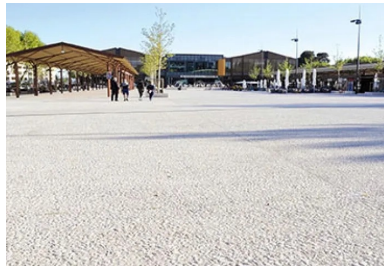
/ Vue générale de la place Jules-Morgan. Au premier plan, le béton de granulométrie 20/40
