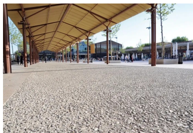
Sous la halle couverte, le béton de granulométrie 20/40 accentue l'aspect minéral de la place.
