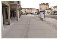
La rue du 4-Septembre (ici côté sud a vu la superficie de ses trattoirs - en béton bouchardé - tripler en superficie. En médaillon : le béton - un C25/30 classé XF2 à base de ciment Vicat CEM 52.5 - intégrant du Comblanchien, de calibre 20/40 et 16/22.
