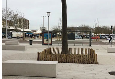
La présence de nombreuses fosses d'arbres et la fréquentation des lieux ont rendu le coulage du béton délicat. Au premier plan, des joints de sciage, dont la présence a été limitée au profit de bandes structurantes en pavé.
