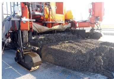
La Wirtgen SP-500, équipée de goudonneuses latérales, en action. Grâce à ses capteurs, elle permet une précision de l'ordre de 5 mm.
