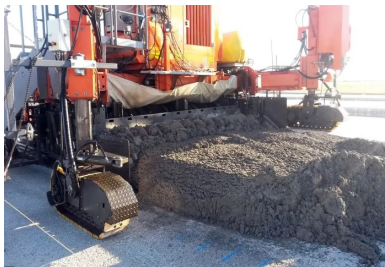
La Wirtgen SP-500, équipée de goujonneuses latérales, en action. Grâce à ses capteurs, elle permet une précision de l'ordre de 5 mm.
