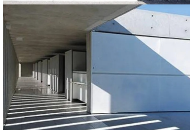
Le parcours allant de l'entrée à la baignade est organisé dans une marche en avant à travers une galerie pleine de lumière éclairée naturellement par le claustra.
