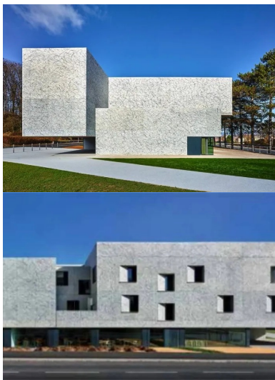
L'entrée est signifiée par un volume en porte-à-faux de 17m dont la mise en lévitation crée un appel.
