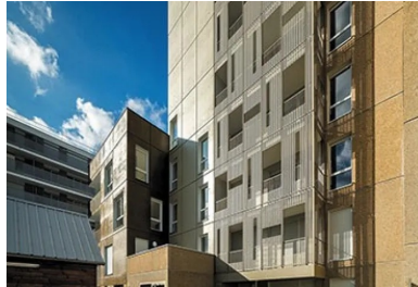
Jeu de contrastes entre le béton lasuré, le béton lavé et les claustras métalliques.
