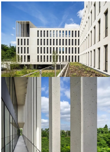
Une pergola accessible double la façade nord.
