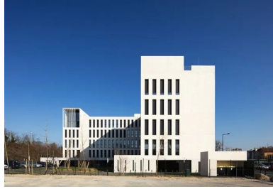
La construction sur pilotis permet l'écoulement des eaux en cas de crue.
