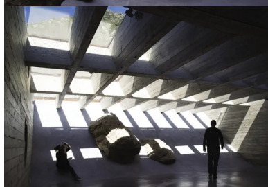
Les poutres croisées en béton portent la verrière. À travers la résille de la structure, des vues cadrées en contre-plongée sur le mont Gerbier-de-Jonc sont proposées aux visiteurs.
