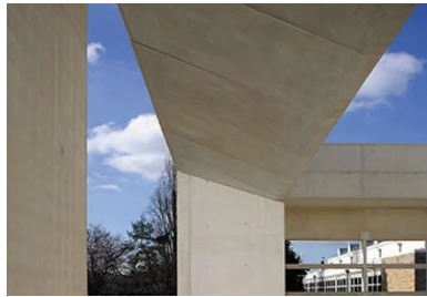
La casquette installée sur la façade arrière, côté stade, fait écho à celle marquant l'entrée principale dans le gymnase.
