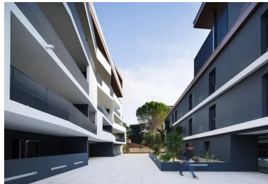
Le parvis entre les deux bâtiments crée un socle commun.
