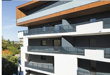
Façade principale du bâtiment haut avec ses grandes loggias orientées sud-ouest dont les rives en béton peint en blanc soulignent le dépiement.
