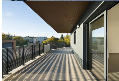
Vaste terrasse partiellement protégée par le porte-à-faux de l'attique qui fait brise-soleil. La matrice du béton et sa lasure brune s'accordent aux pins parasols.
