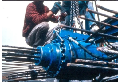
Figure 9 : Vérin de mise en tension.
