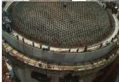
Figure 13 : Enceinte de confinement d'une centrale nucléaire.
