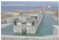
Figure 14 : Digue flottante de Monaco sur le site de construction d'Algeciras (Espagne).
