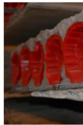
Figure 11 : exemple de planchers alvéolaires précontraints.
