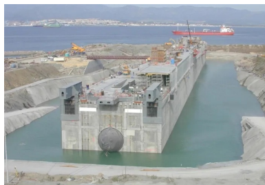
Figure 14 : Digue flottante de Monaco sur le site de construction d'Algeciras (Espagne).
