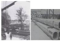
igure 5 : Précontrainte de oteaux électriques en béton Montargis 1933).
