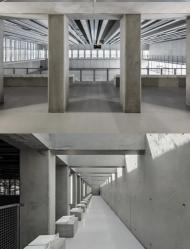
À l'intérieur, le bâtiment est rythmé par la trame de 1,80 m, sur laquelle est calé l'ensemble du bâtiment et notamment la succession de poutres précontraintes qui soutient la toiture.
