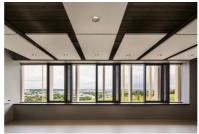
Les plafonds en béton laissé apparent participent à la recherche de frugalité énergétique en jouant sur l'inertie du matériau.
