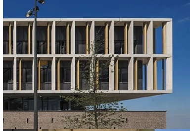
Les brise-soleil en béton assurent une protection efficace et dégagent une galerie à la manière d'un péripptère.
