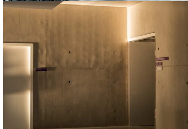
La présence intérieure du béton favorise la pérennité du bâtiment et l'inertie thermique.
