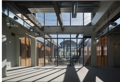
Au cœur de l'édifice, un patio triple hauteur, créé par la suppression de 4 000 m 2 de planchers, assure une réponse environnementale en termes de ventilation, de rafraîchissement, de désenfumage et de lumière naturelle.
