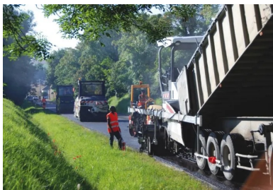
Application de la couche de roulement après retraitement des zones endommagées (10 000 t de BBSG 0/10 avec 30 % d'agrégats d'enrobés).
