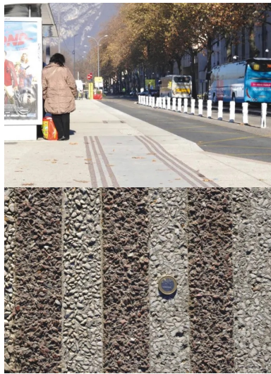
Des bandes rugueuses de couleur grenat, créées sur le béton désactivé, signalent la présence de voies cyclables.
