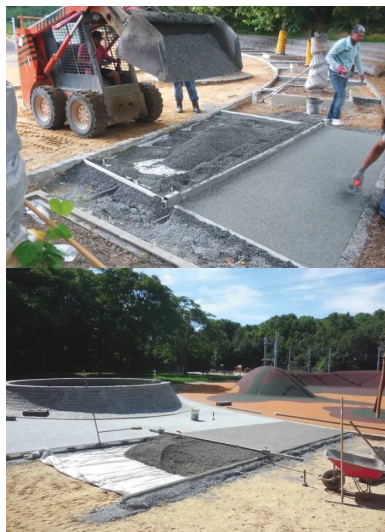
Le béton a été acheminé à l'aide d'une chargeuse et mis en œuvre manuellement par l'équipe de Val-de-Loire Environnement.
