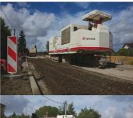
En milieu urbain, la présence de bordures, de tampons de voirie ou de bouches à clé n'empêche pas la mise en œuvre du retraitement en place. Solution choisie par Elifage-Route sur ce chantier : les abaisser, avant de les relever
