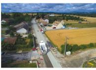
Fin juin 2017, à Demigny (Saône et-Loire). Après épandage du liant hydrauliqui routier Vicat (LV-TS03) par l'Arc Dosage (en haut de la photo), l'Arc 1000 (au prenie plan) déconèsionne les matériaux de l'ancienne chaussée et procéde à un puissant malaxage pour obtenir un mélange homogène.
