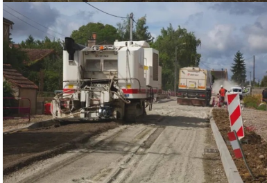
L'ARC 1000® permet d'homogénéiser la structure existante sur toute la largeur de la chaussée.
