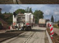
L'ARC 1000® permet d'homogénéiser la structure existante sur toute la largeur de la chaussée
