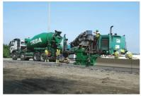
Sur le nouveau tronçon, 500 m de dispositifs de retenue en béton ont été
